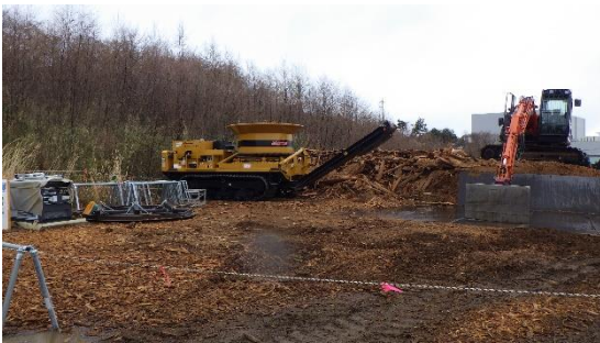
(写真2-2) 重機等の配備状況
