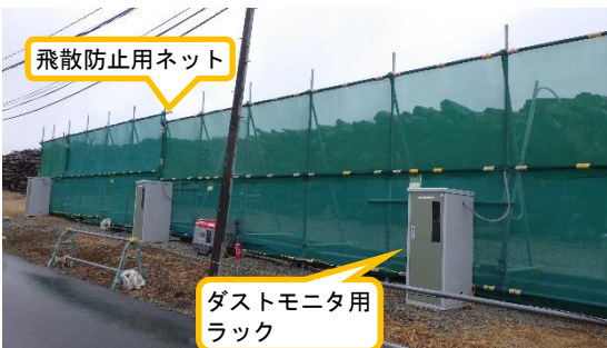
(写真2-3) 飛散防止用ネット及びダストモニタの設置状況
