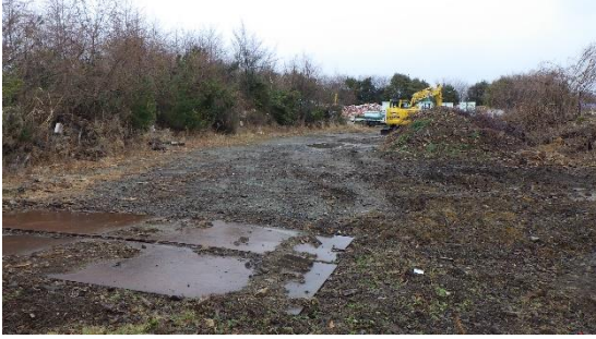
(写真 1 - 2) エリア中央における伐採木の処理状況
