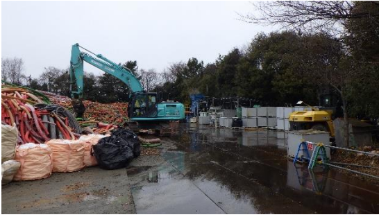
(写真1-6) エリア北側における使用済フレキシブルホース処理作業の実施状況
