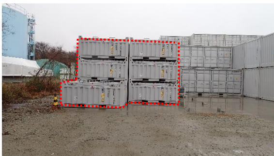
(写真 5 - 1) P 1 エリアにおける保管用コンテナ 7 基の保管状況①
