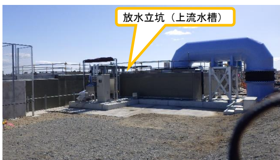
(写真 1 - 4) 放水立坑 (上流水槽) の状況 (北西側から撮影)
