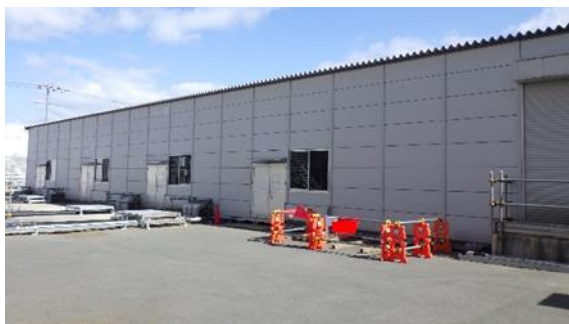
(写真 1 - 2) 多核種移送設備建屋外観 (南西側から撮影)
