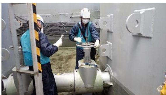
(写真 2 - 2) サンプルタンク B 群の連結弁「全 開」操作の状況
