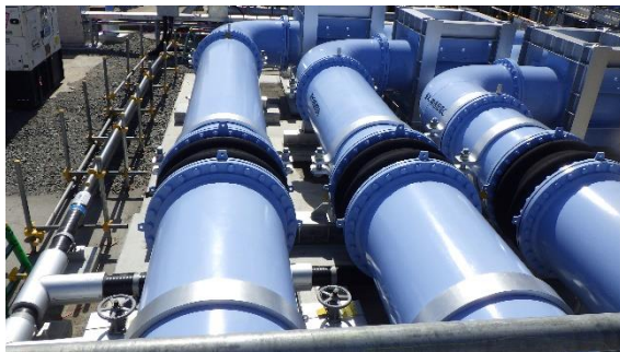
(写真 3 - 3) 海水移送配管の状況 (北側から撮影)
