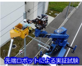
先端ロボットによる実証試験
