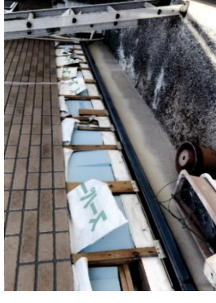
被災住宅の応急修理
