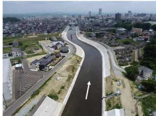
逢瀬川 河川改修事業（整備状況）
