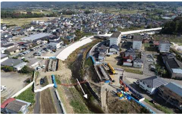
塩野川 河川改修事業（整備状況）
