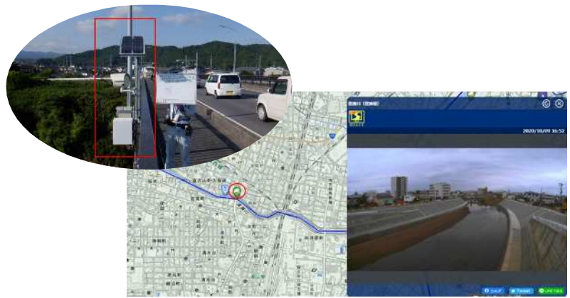
簡易型河川監視カメラ型の設置
