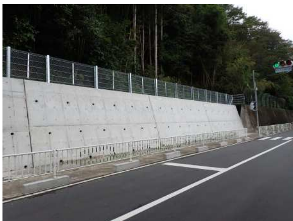
法面对策状況 (一) 小川赤井平線<いわき市>
