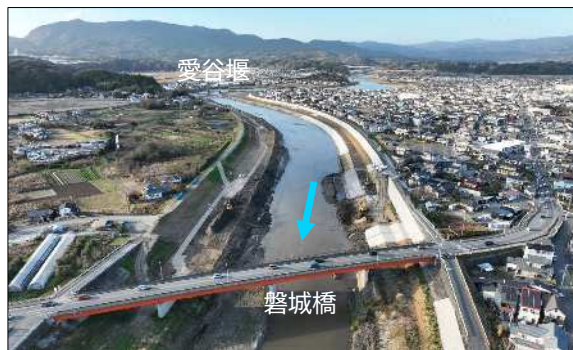
夏井川 河川改修事業（整備状況）
