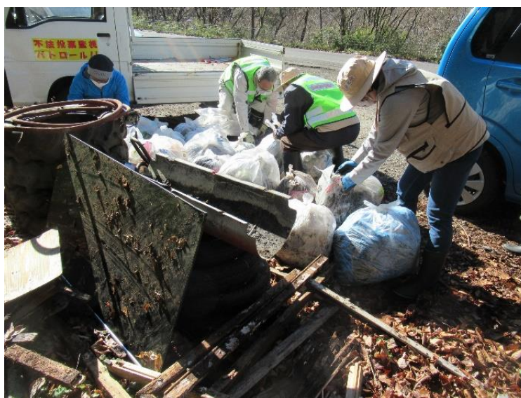
建設系廃棄物等の撤去
