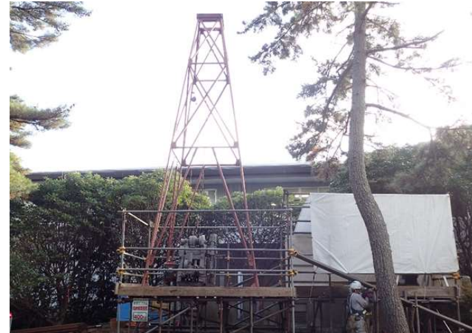
ボーリング調査状況
