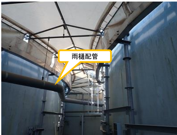
(写真4) 雨樋配管の状況
