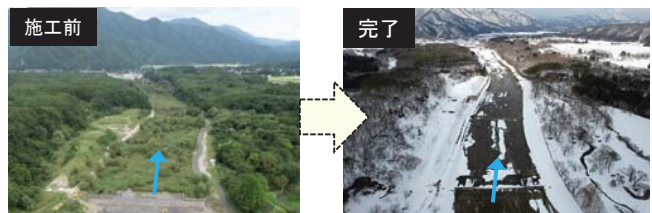
(河道掘削) 加藤谷川(下郷町)
