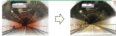
<トンネル照明の灯具をLEDに更新しCO2を削減>
