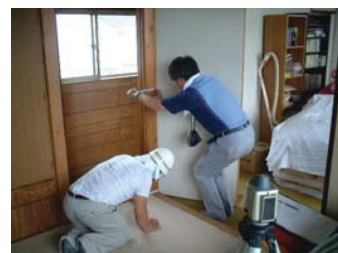
<耐震診断の実施状況>
