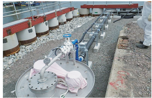
海側遮水壁と地下水ドレンpond
