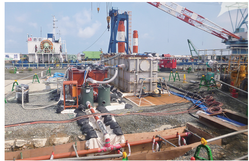
ウェルポイントによる汚染地下水汲み上げ
