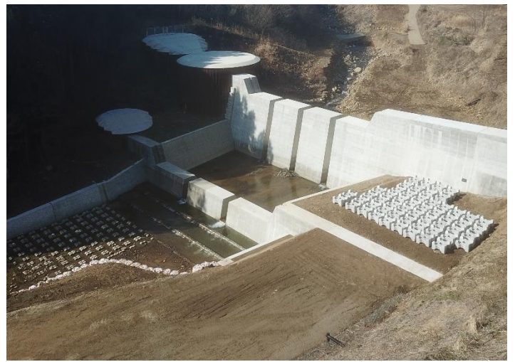
砂防えん堤施工中（東八川筋） [福島市松川町水原]
