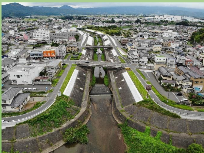
【背水対策工事】 安達太良川
