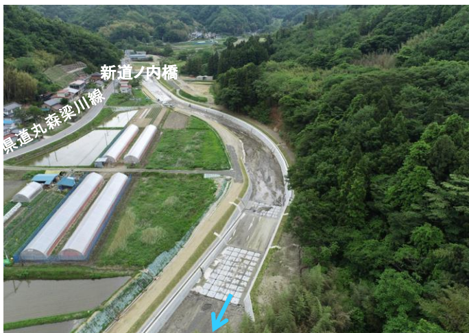
山舟生川（伊達市梁川町山舟生） 護岸整備状況
