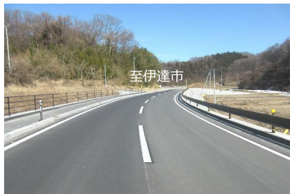
国道349号 杉沢工区 (二本松市)
