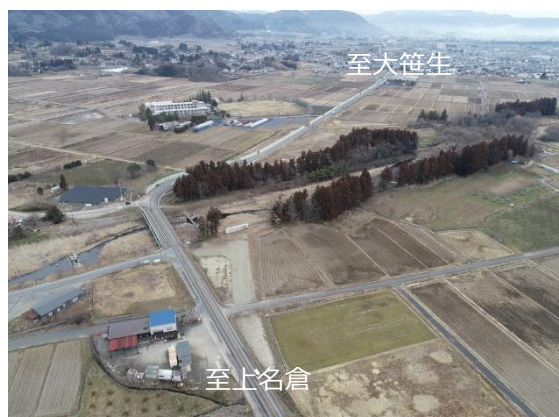
至大笹生 至上名倉 上名倉飯坂伊達線 天戸橋工区（福島市町庭坂）
