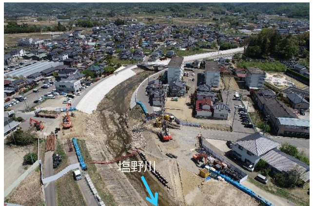
塩野川（伊達市梁川町） 堤防・護岸整備状況
