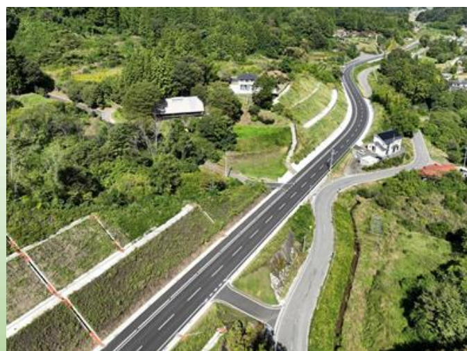
【ふくしま復興再生道路】 国道349号大綱木工区
