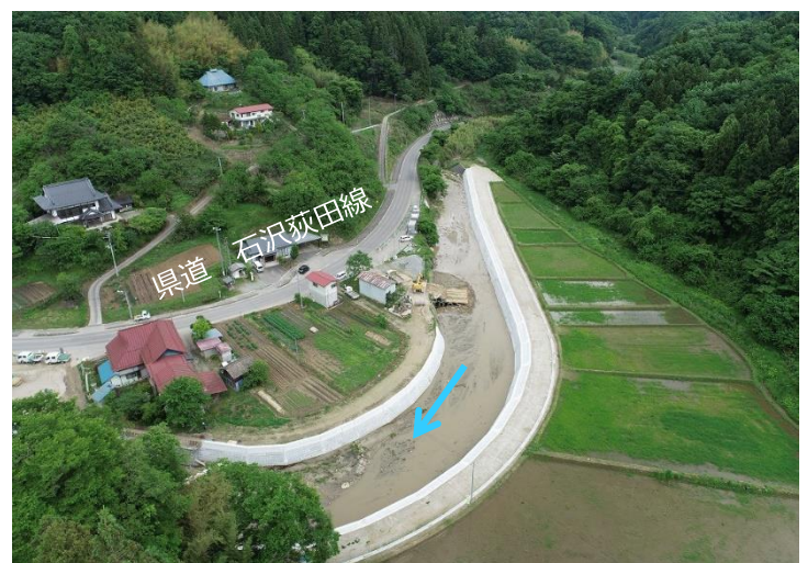
安達太田川（二本松市太田） 護岸整備状況
