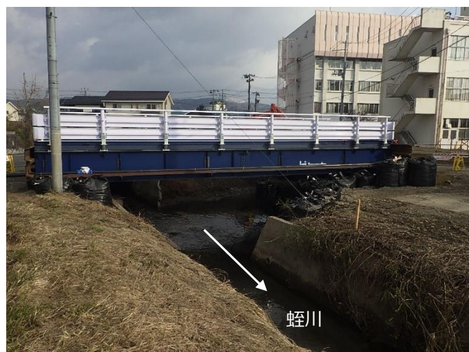
蛭川（福島市瀬上町）田尻橋仮橋工
