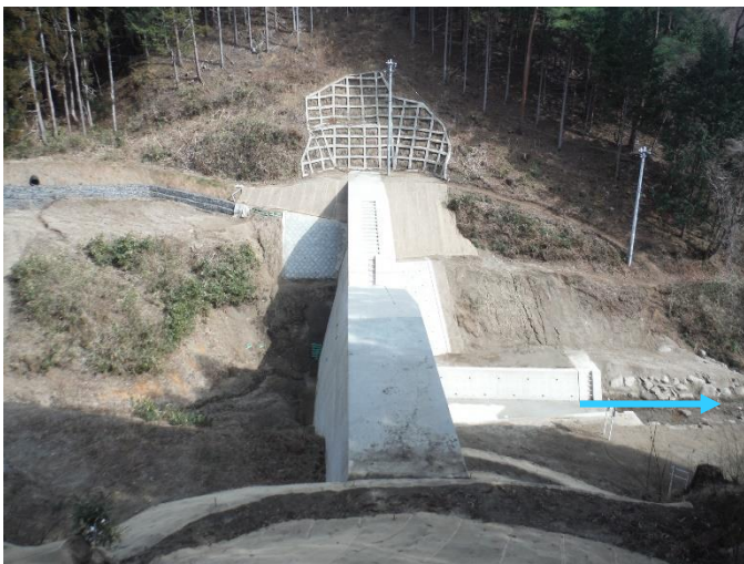
R2砂防えん堤完了（七曲の沢筋） [川俣町七曲]
