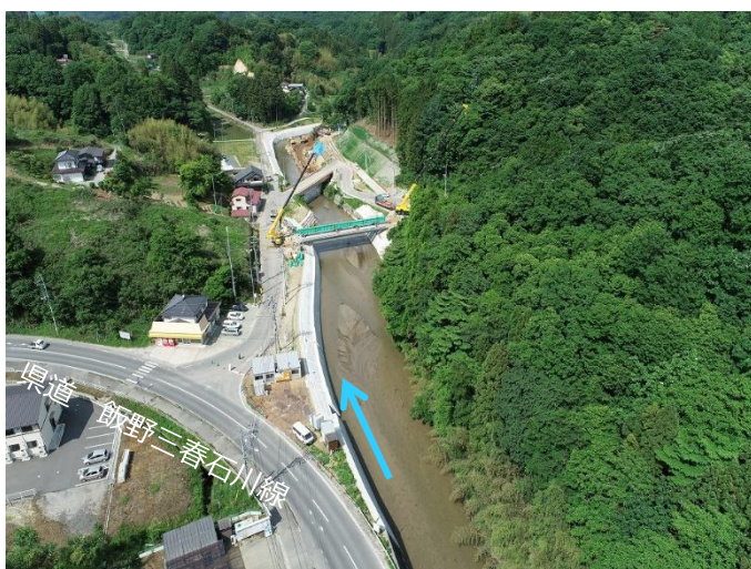
移川（二本松市上長折） 護岸整備状況
