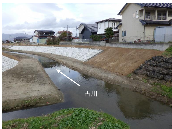
古川（伊達市保原町）開削護岸
