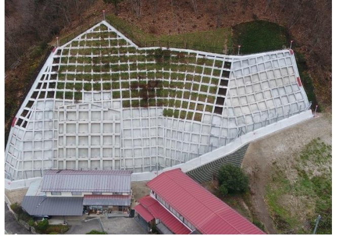
R4法面工完了[二本松市百目木]
