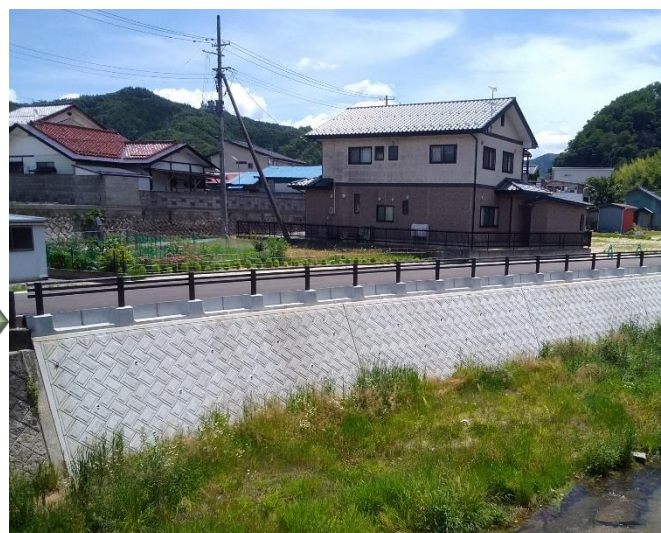
広瀬川（伊達郡川俣町川原田） 整備完了箇所
