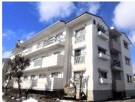
県営住宅改善工事（外壁改修）上並松団地 (R5.2竣工)
