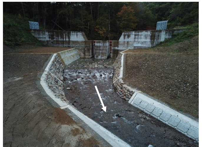
H31砂防えん堤完了（藤入川筋） [福島市松川町水原]
