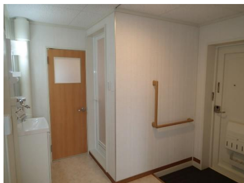
改修による手すりの設置等 《県営蓬莱団地（福島市）》
