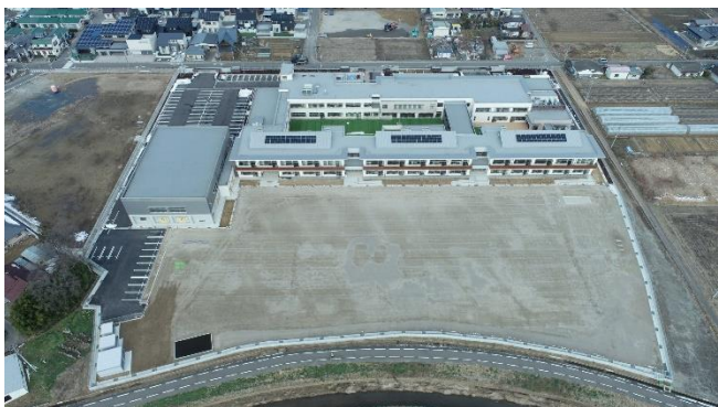
伊達地区特別支援学校 新築工事 (R4.8竣工)
