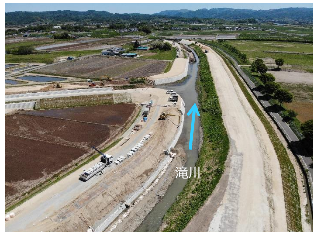
滝川（伊達郡国見町） 堤防整備状況
