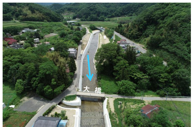
広瀬川（川俣町小島）護岸整備状況
