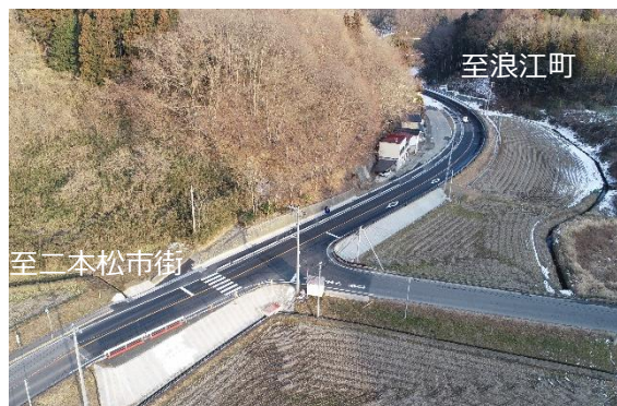
国道459号 沼ヶ作工区 (二本松市沼ヶ作)
