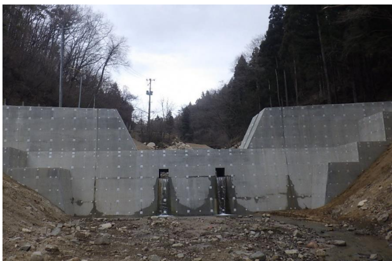
山舟生川砂防えん堤（梁川町）
