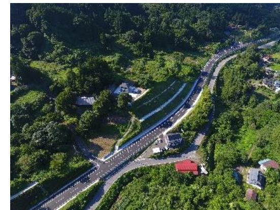
国道349号（川俣町大綱木工区） 2023年3月21日 完成
