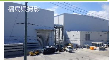
固体廃棄物貯蔵庫第10棟の外観（左：B棟、右：A棟）
