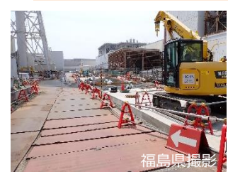
フェーシング前（3号機付近）
