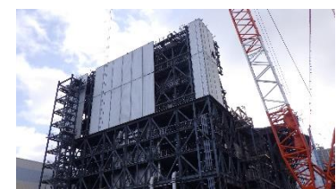
1号機の大型カバー設置の様子
