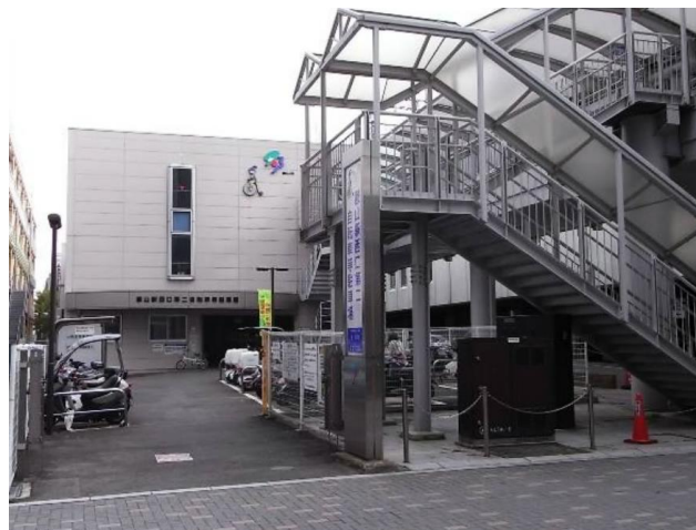
写真 2-7 郡山駅西口第二自転車等駐車場（出典：郡山市 HP）
