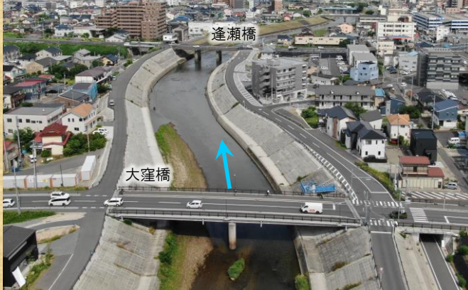
① 逢瀬橋から大窪橋までの区間 【令和7年6月撮影】
