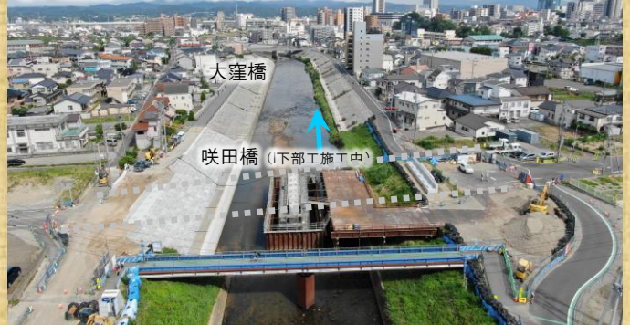
② 大窪橋から咲田橋までの区間 【令和7年6月撮影】
