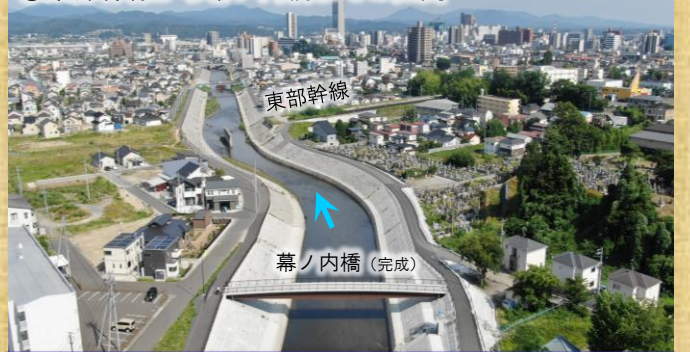
④ 東部幹線から幕ノ内橋までの区間 【令和7年6月撮影】
