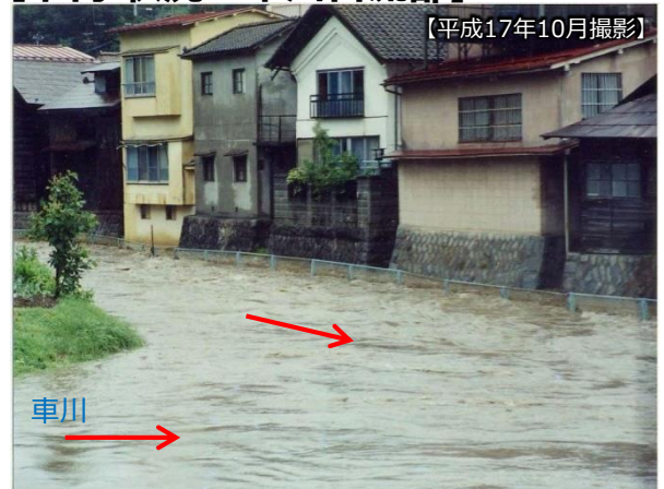
【出水状況：車川合流部】
