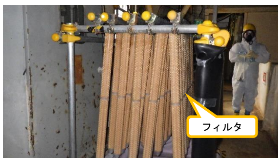
(写真 1－2) 使用済フィルタの仮置き状況
