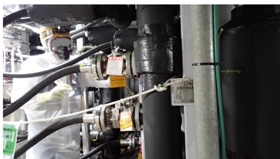
(写真 3) ホース及びフランジ部の点検作業の状況
