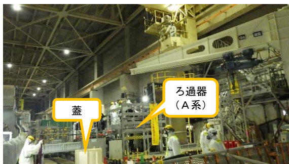
(写真 1－1) フィルタの交換作業の状況
