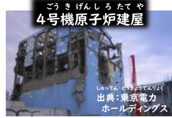
4号機原子炉建屋 水素爆発 (2011年3月15日)
