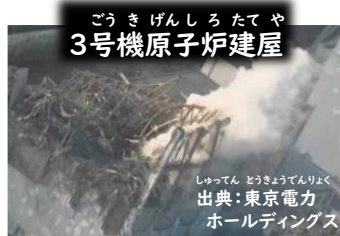
3号機原子炉建屋 水素爆発 (2011年3月14日)
