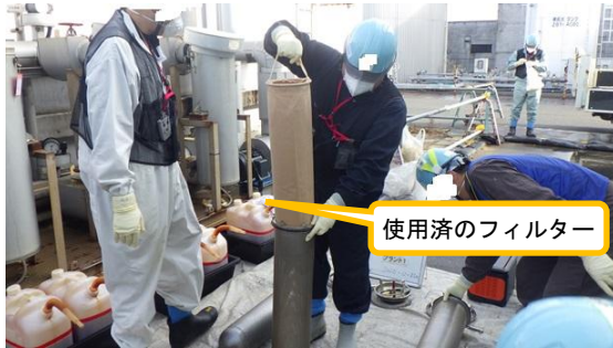
(写真 2－2) フィルター交換作業の状況②
