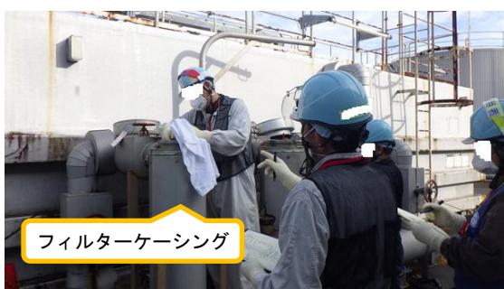
(写真2-1) フィルター交換作業の状況①
