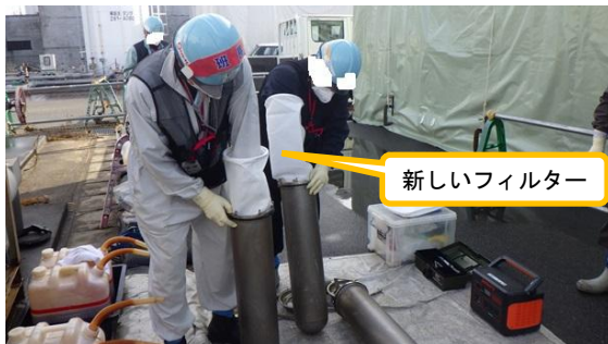
(写真 2－3) フィルター交換作業の状況③
