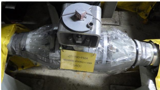
(写真 7－3) 弁の状況 （漏えい防止策で接続部がビニールで養生されている）
