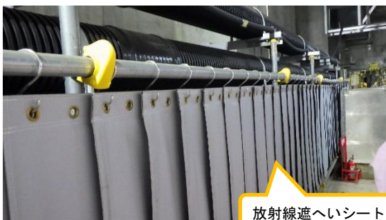
(写真 8－1) 放射線遮へいシートの設置状況①
