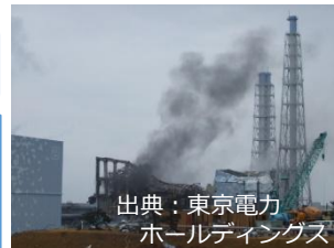
水素爆発を起こした直後の3号機
