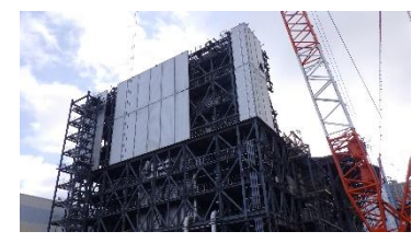
1号機の大型カバー 設置の様子
