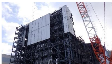
1号機の大型カバー 設置の様子
