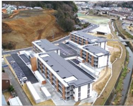
いわき市：磐崎団地
