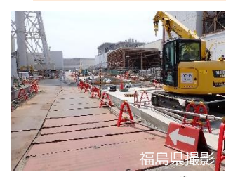
フェーシング前 (3号機付近)
