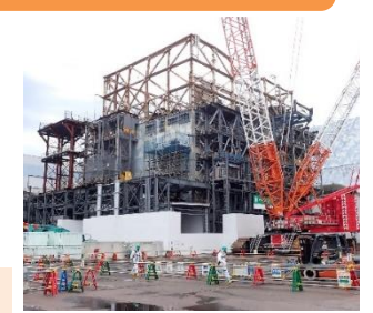
1号機の大型カバー設置の様子
