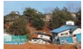
家屋被害：福島市
