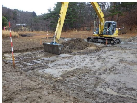
ため池の底質を掘削除去する様子
