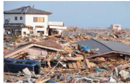
津波被害：浪江町
