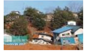
家屋被害：福島市
