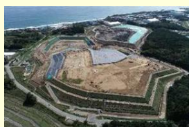
中間貯蔵施設の様子
