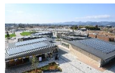
大熊町：商業施設
