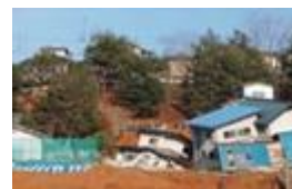
家屋被害：福島市
