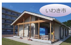
公営住宅敷地内：集会場
