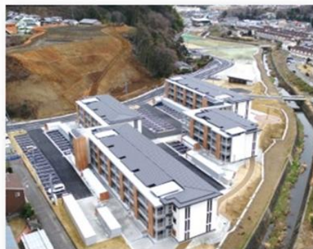
いわき市：磐崎団地
