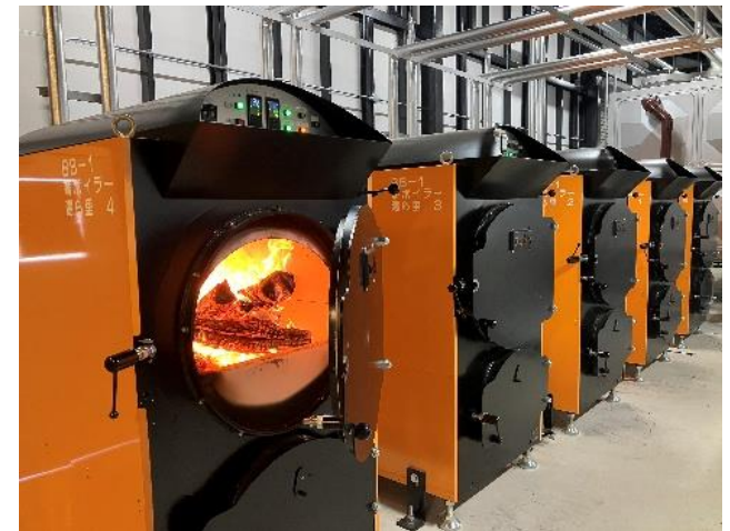
只見町 バイオマス熱利用設備（340 kW） （令和7年度事業完了）
