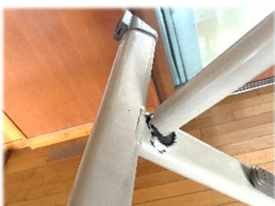
生徒用椅子破損個所の修繕
