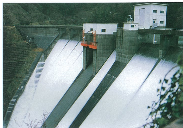
洪水調節により洪水吐から全面越流した真野ダム
