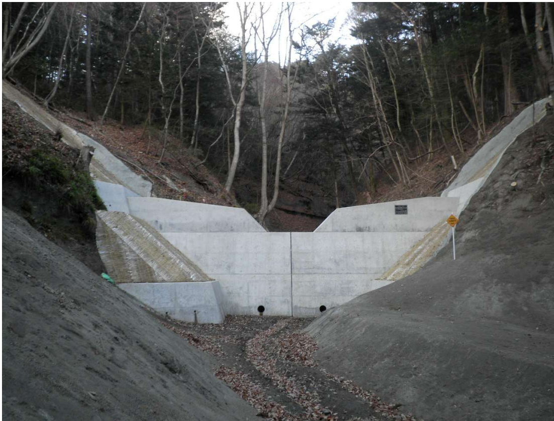
中島地区治山施設工事（飯館村）
