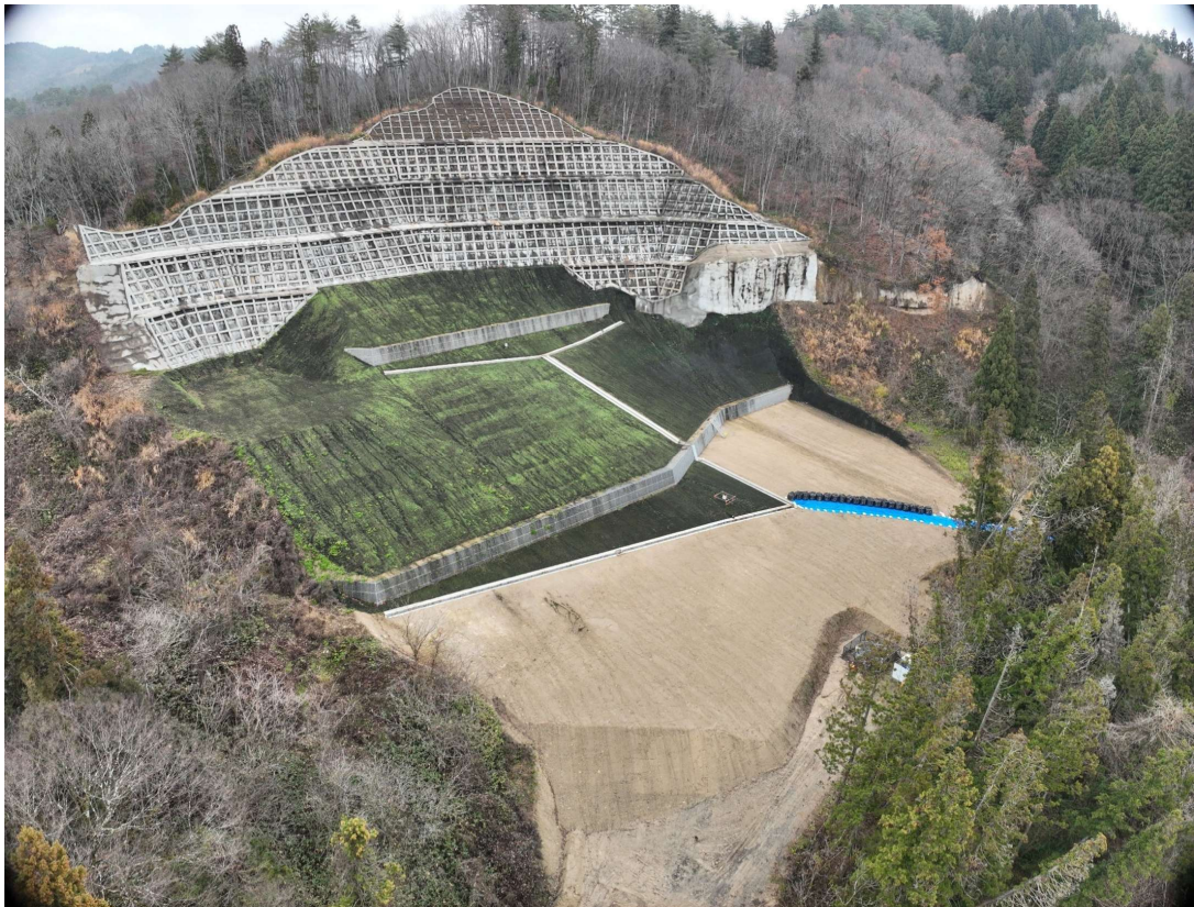
藤沢地区地すべり対策工事（喜多方市）
