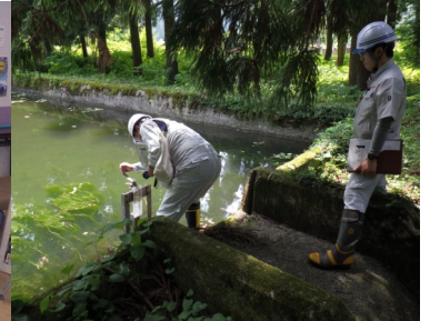
農業水利施設の合同診断
