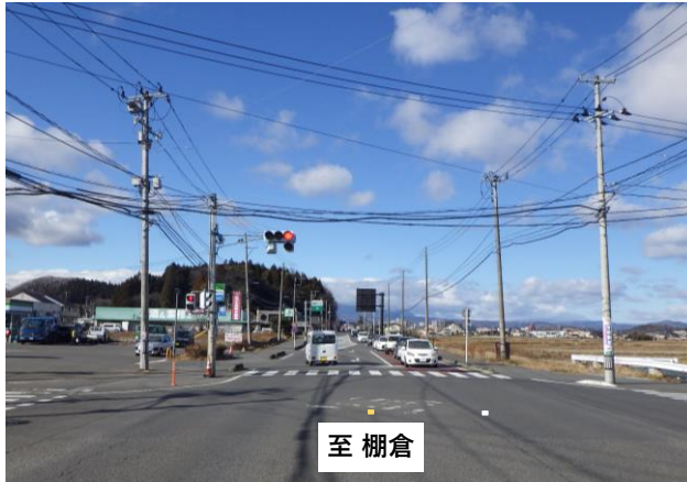
《国道289号（立石3工区）》
