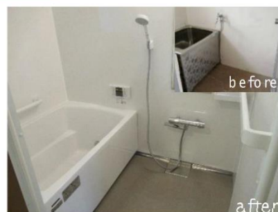
②浴室へユニットバス(シャワー付き混合水栓付き)・手すり設置
