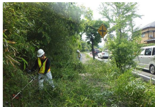
【補修作業（歩道除草の様子）】
