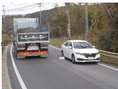
⑤ 棚倉町 (山本不動線) 中ノ内工区整備
