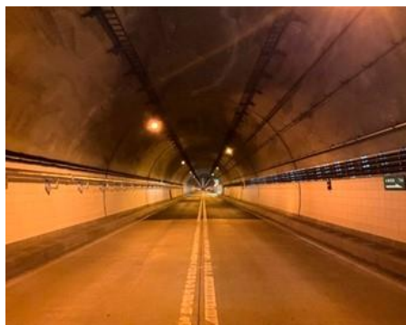
《 国道289号（甲子トンネル） 》
