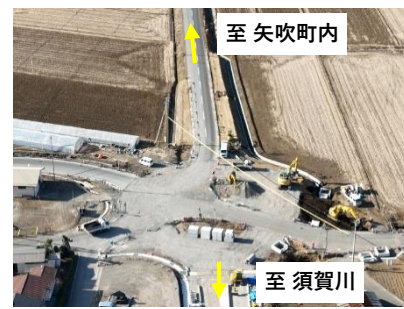
④ 矢吹町 (須賀川矢吹線) 寺内工区整備
