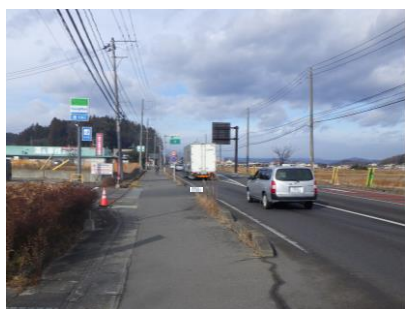
② 白河市 (国道289号) 立石工区整備
