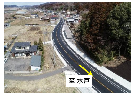
⑦ 矢祭町 (国道118号) 並木工区整備
