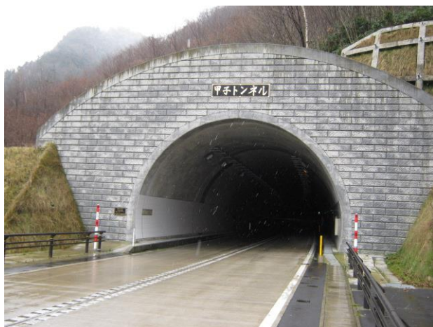
【甲子トンネル下郷側坑口】
