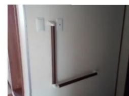
④玄関へ手すり設置
