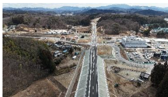
国道288号(船引バイパス) 2026年3月28日 開通
