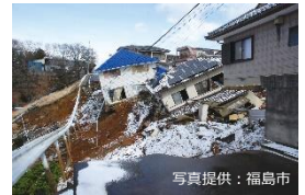
家屋被害：福島市
