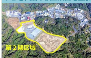
いわき四倉中核工業団地全景
