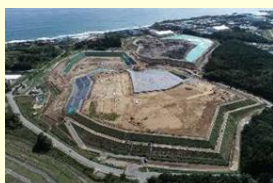
中間貯蔵施設（大熊⑤工区）の様子
