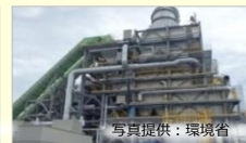
仮設焼却施設
