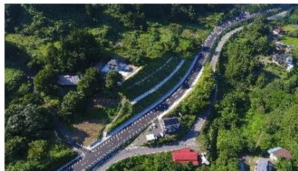
国道349号(大綱木工区) 2023年3月21日 完成
