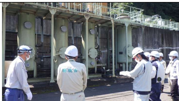
○浸出水処理施設 異常なし
