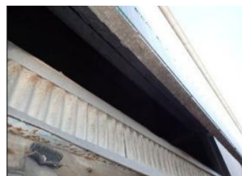
入気口の隙間
