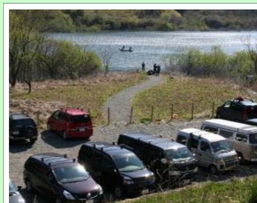
施工後(駐車場)
