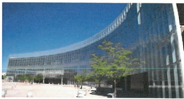
メサデルソルセンタービル(負荷400kW)
