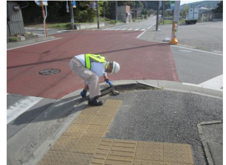
応急補修作業
