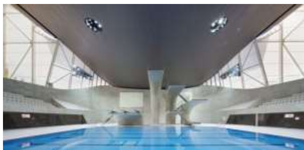
水泳競技施設(天井に使用)
