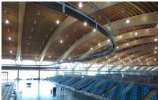
屋内スケートリンク(梁、天井に使用)
