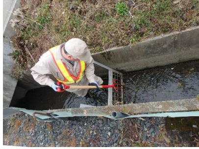
側溝清掃作業
