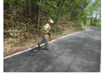
支障木撤去作業
