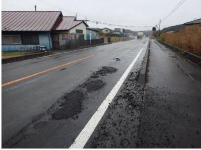
道路補修作業
