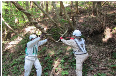
支障木撤去作業
