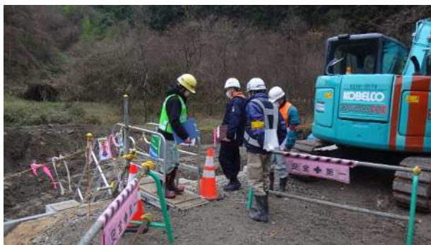
点検状況<須賀川、石川方部>
