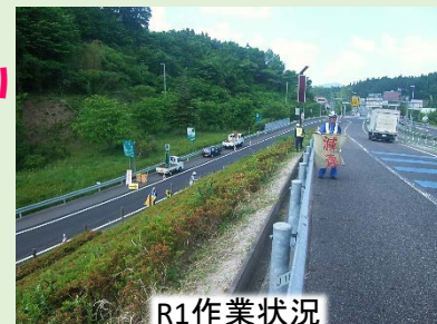
R1作業状況
