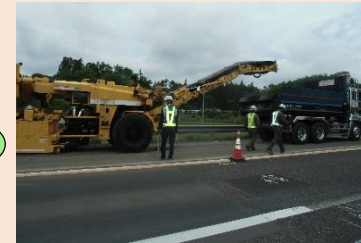
特殊な機械で舗装面を削っている状況です
