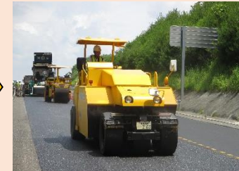
アスファルト舗装を転圧している状況です
