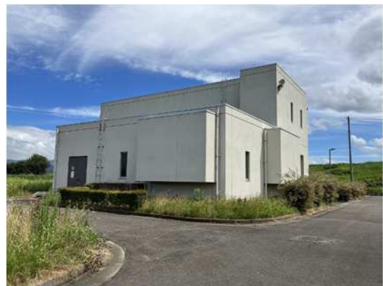
耐水化（放流ポンプ棟）
