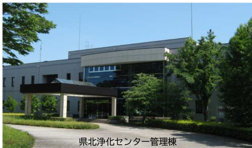
県北浄化センター全景
