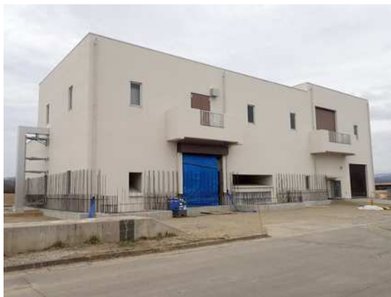
耐水化工事中（第2SP棟）
