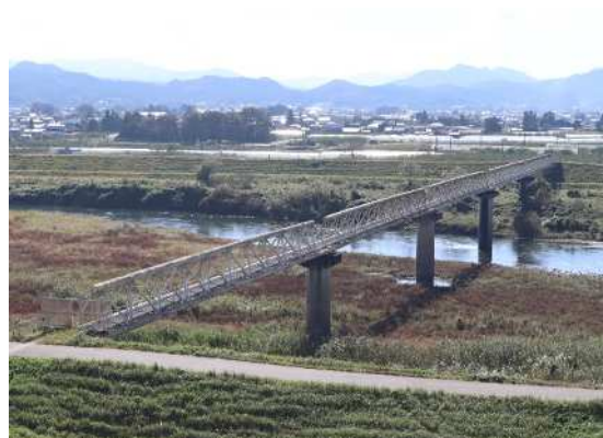
徳江水管橋撤去
