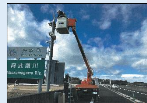
設備点検状況
