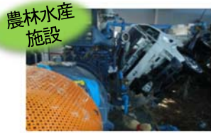
八沢排水機場（相馬市）
