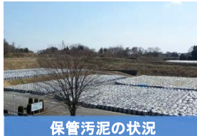
保管汚泥の状況
