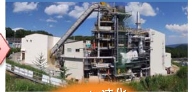
飯館村小宮仮設焼却炉
