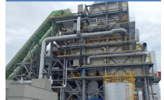
浪江町仮設焼却炉
