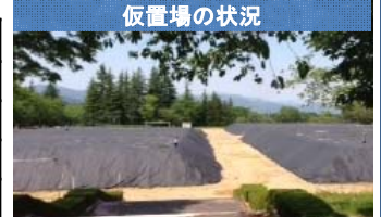
仮置場の状況
