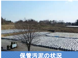
保管污泥の状況
